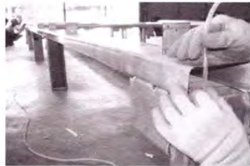
Kontrol siku dan leveling ring balok
